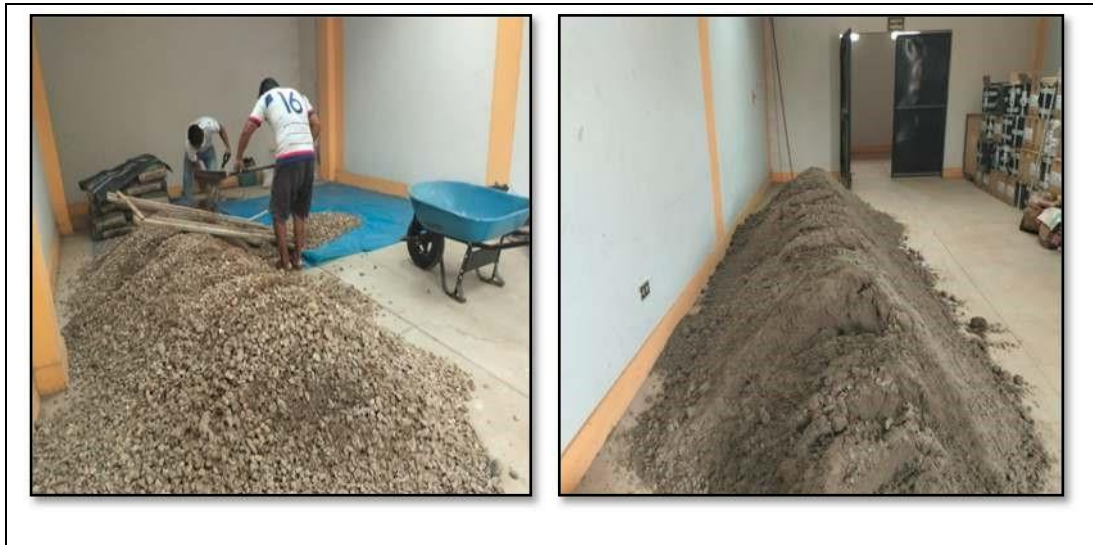
Figura 19 Almacenamiento de agregados (Piedra chancada 1") y arena
