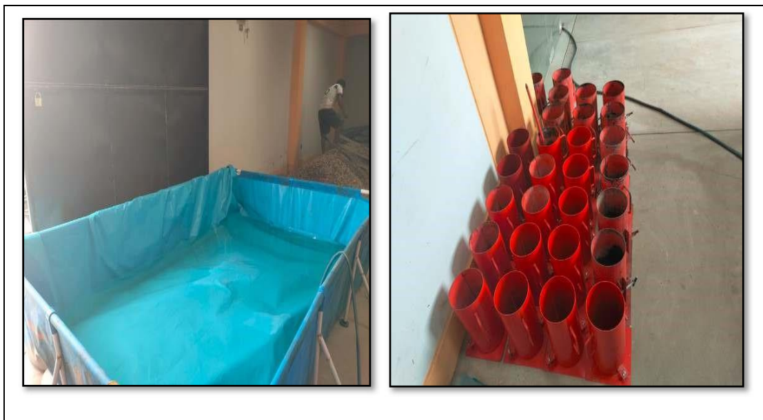
Figura 20 Habilitación de Poza de Curado y Moldes de Probetas
