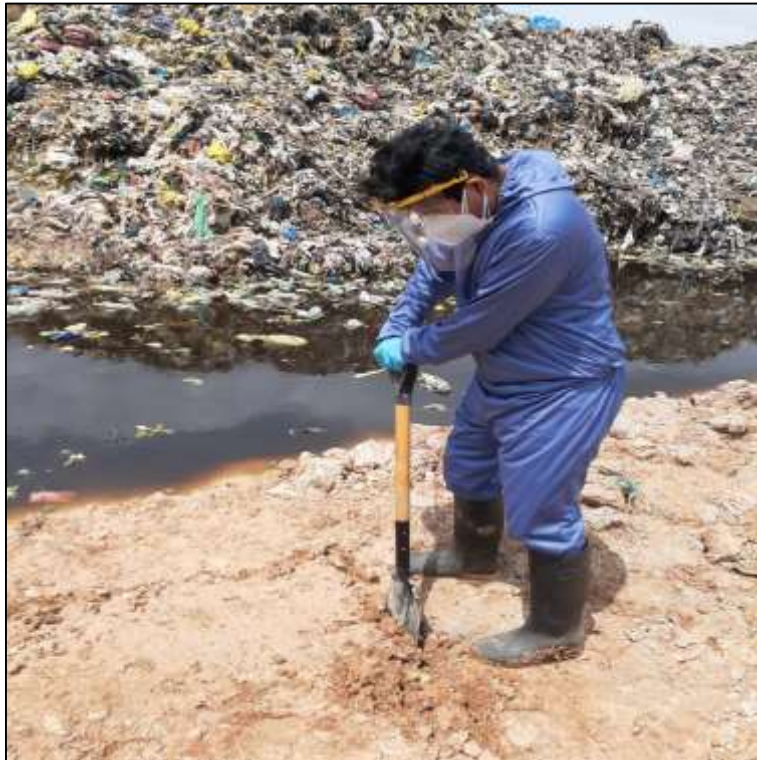
Figura 44. Excavación de calicatas
