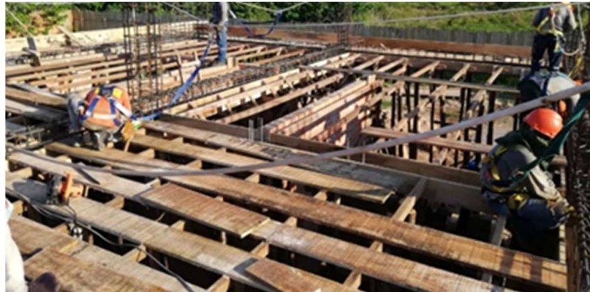
Figura 22: Encofrado en losa aligerada
