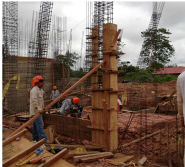
Figura 16: Encofrado en columnas típicas
