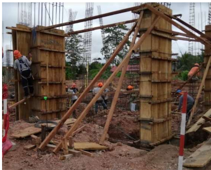
Figura 20: Desencofrado en columnas típicas
