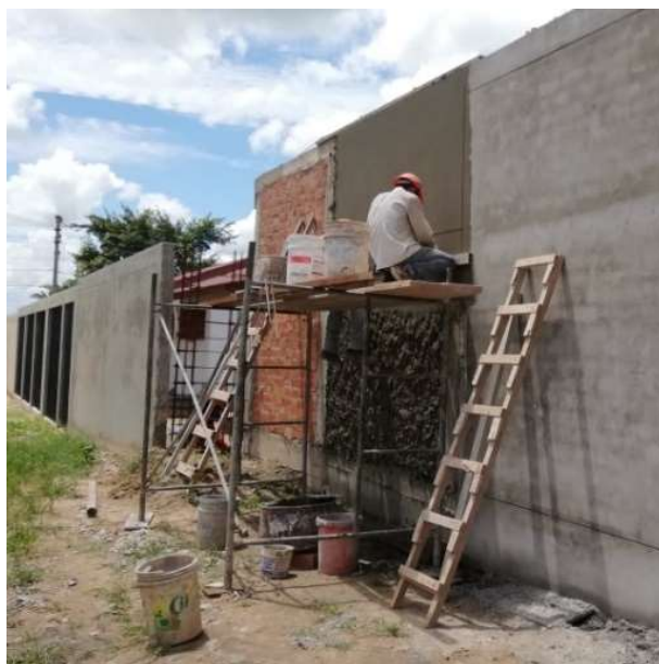
Figura 30: Tarrajeo de muros exteriores
