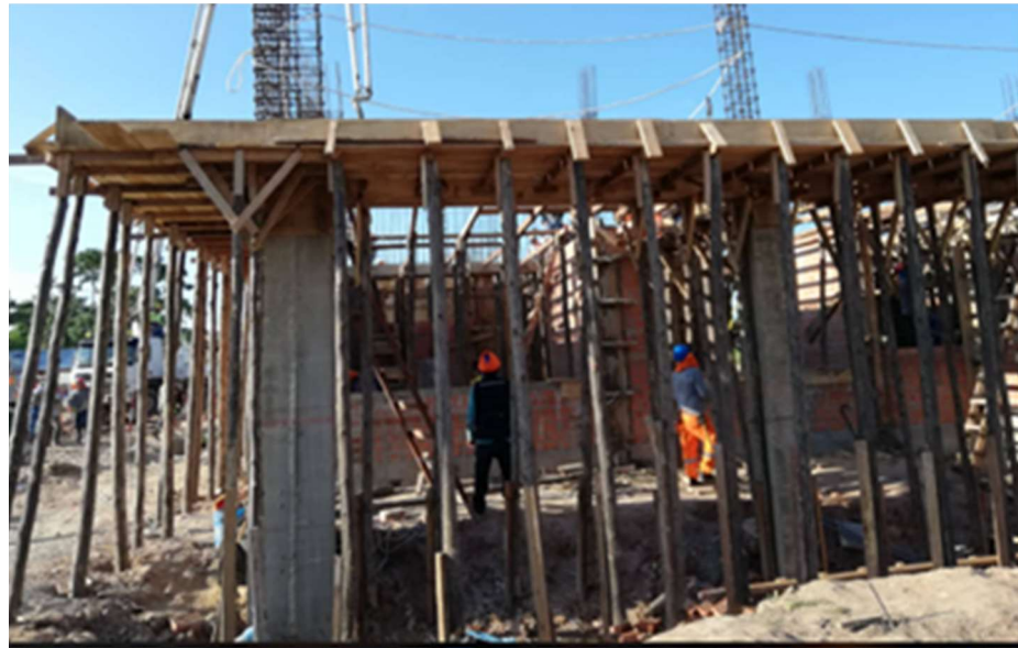
Figura 26: Desencofrado de losa aligerada
