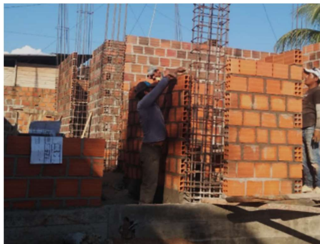
Figura 28: Asentado de muro de ladrillo tubular de canto
