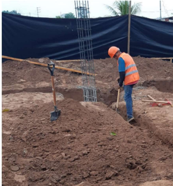
Figura 4: Excavación Manual de Zanjas de Viga de Cimentación
