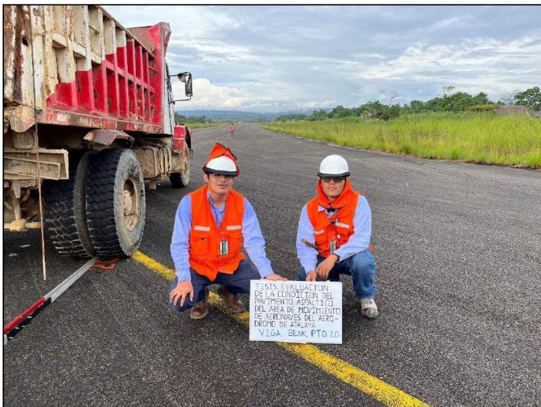
**Fotografía 13.** Pto. 20 – Ensayo de deflectometría con Viga Benkelman – Lado izquierdo Pista de aterrizaje.
