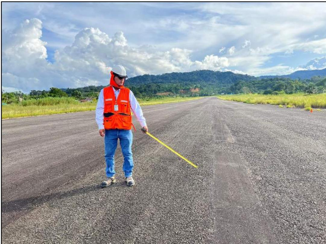
**Fotografía 38.** En la UM-54 se tiene falla Parcheo con severidad media.
