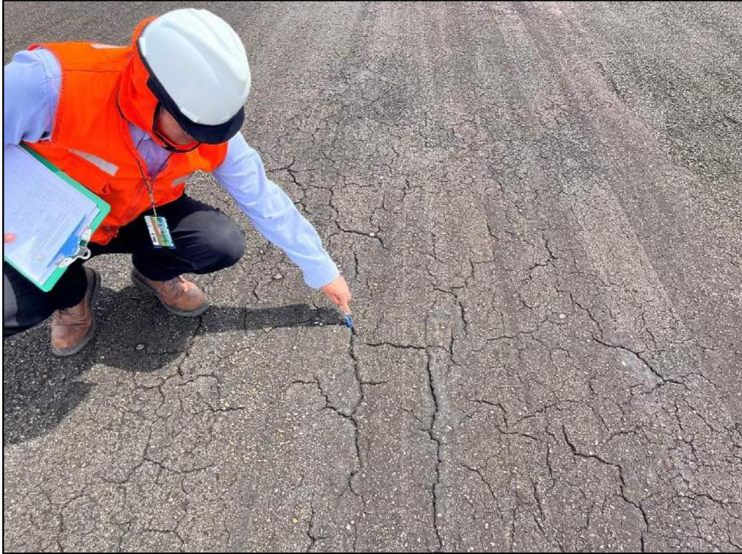
**Fotografía 35.** En la UM-42 se encontró la falla Piel de Cocodrilo con severidad grave.
