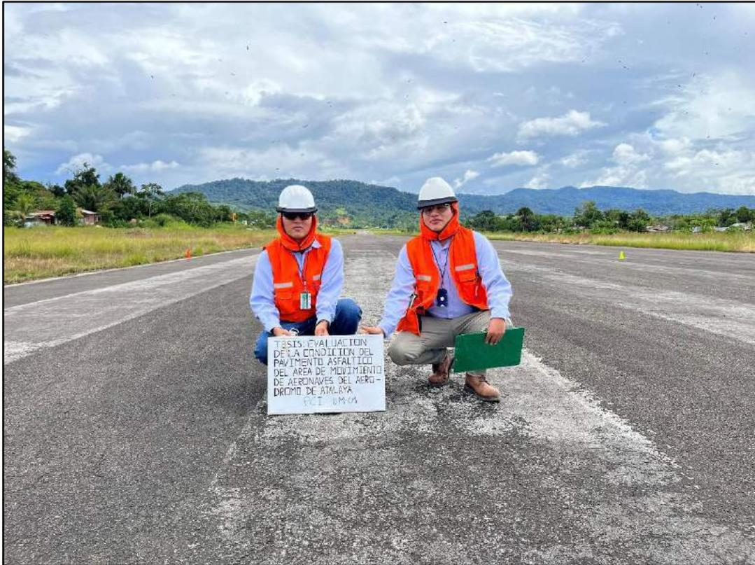
**Fotografía 31.** UM-01 para el cálculo del PCI.
