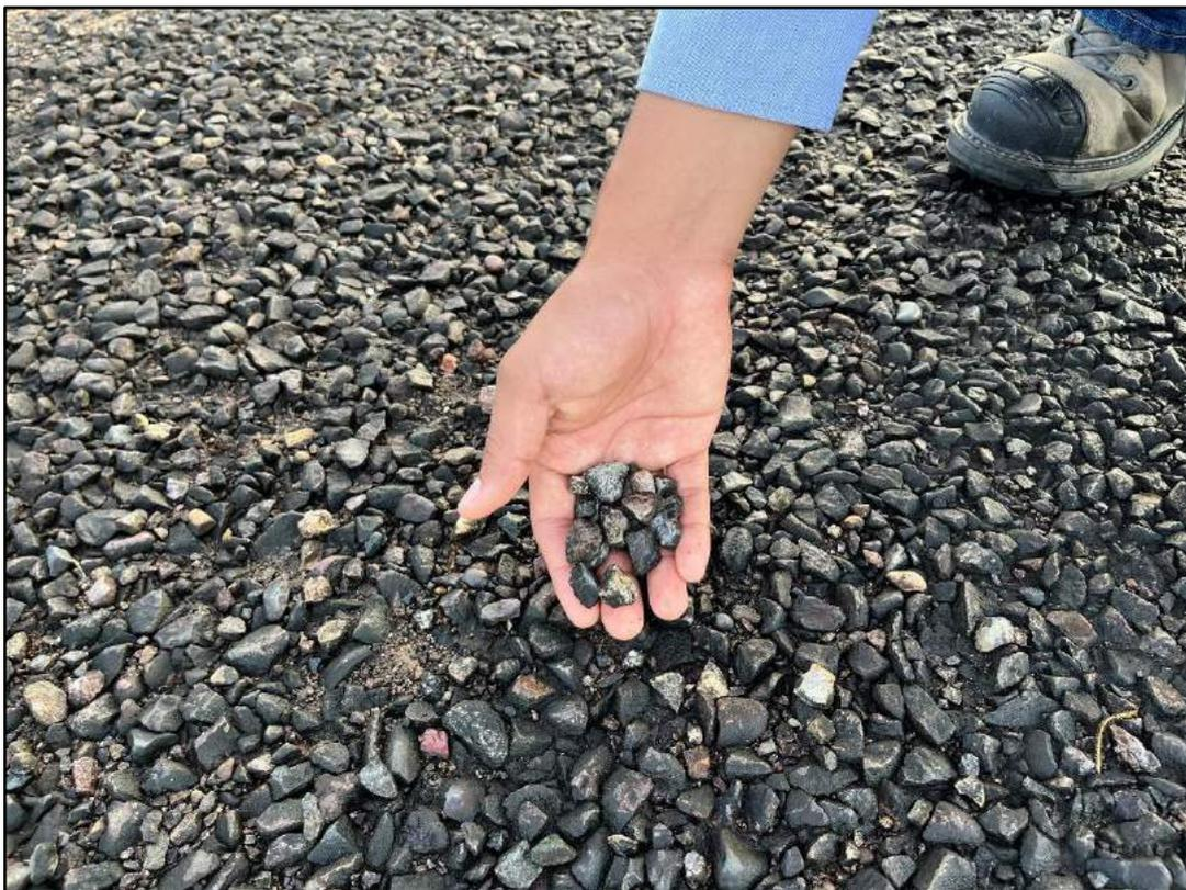
**Fotografía 34.** En la UM-15 se encontró la falla Peladura y efecto de la intemperie con severidad media.
