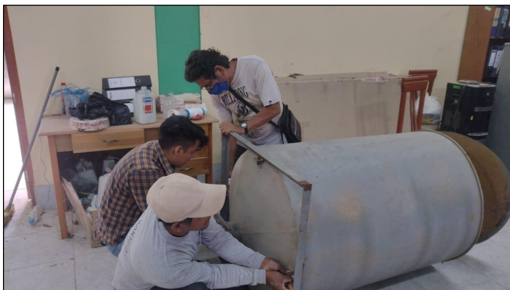
Figura 47. Armado de tanque de captación del Prototipo SETAR
