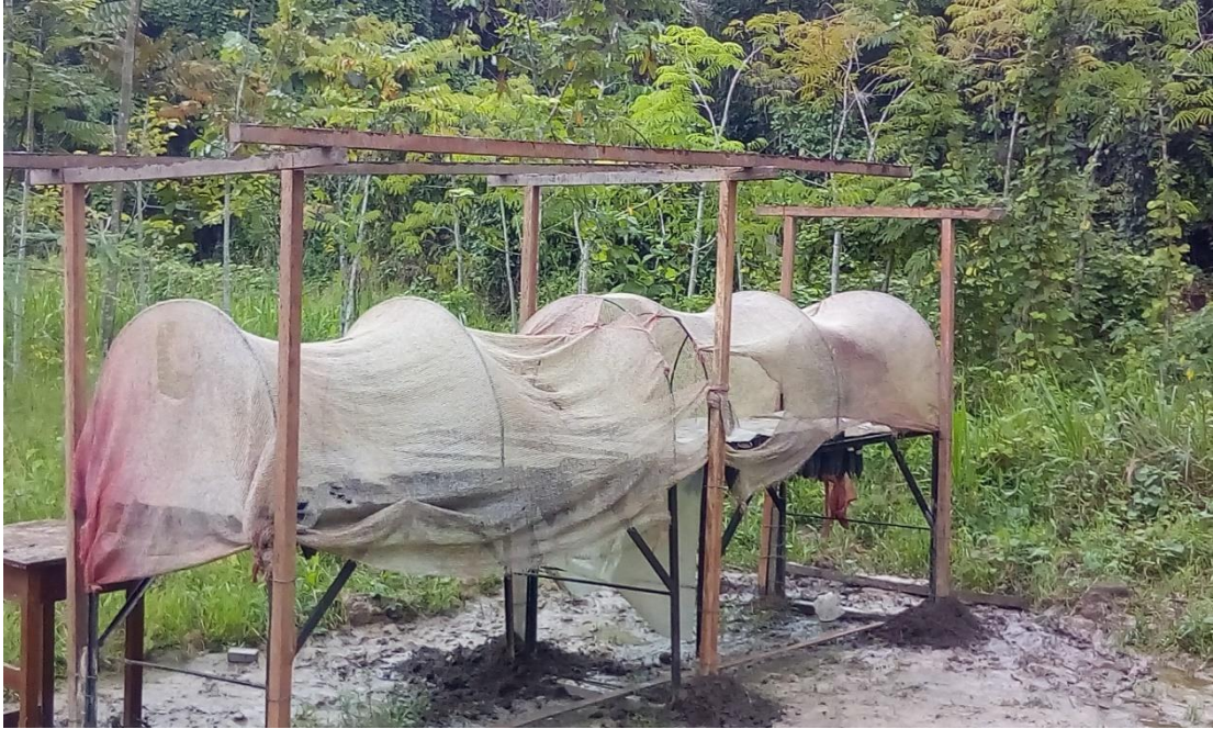
Figura 11. Instalación de parantes para la malla raset
