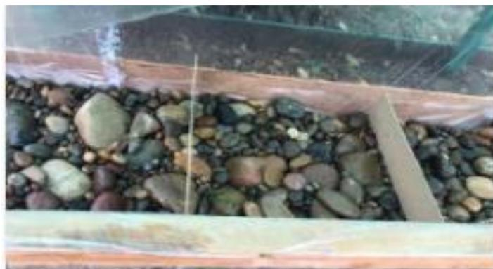
Foto 8. Construcción de cámara de sub-irrigación.
