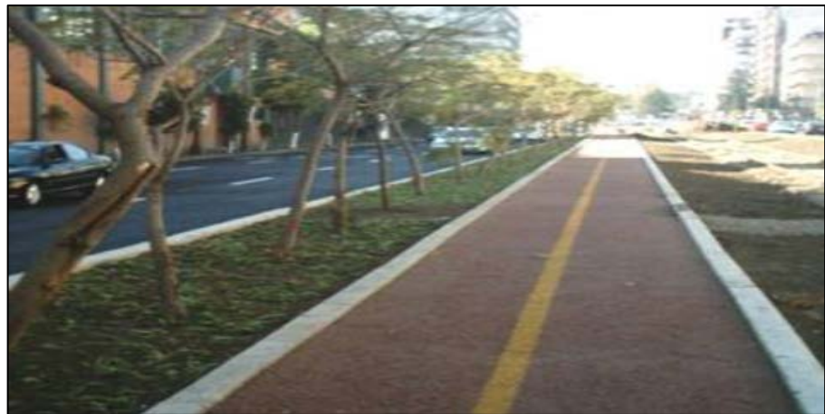
Figura 2. Concreto permeable en pavimento de tránsito ligero. Fuente: CAP. IV. "CONCRETO HIDRAULICO PERMEABLE" (U.N.A.M.).
