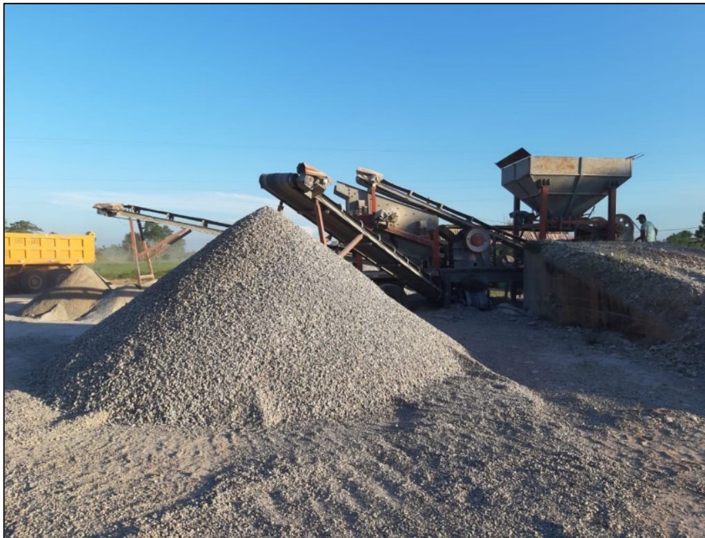
Imagen 2. Planta Chancadora del Km 15.
