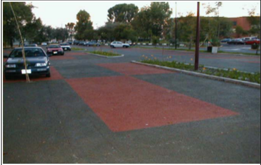
Figura 3. Concreto permeable en pavimento de tránsito ligero. Fuente: Cap. iv. "Concreto Hidráulico Permeable" (U.N.A.M.).
