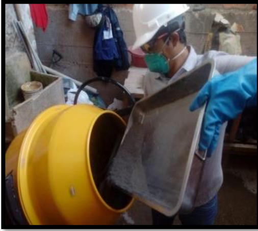
Figura 76 Adición del cemento.
