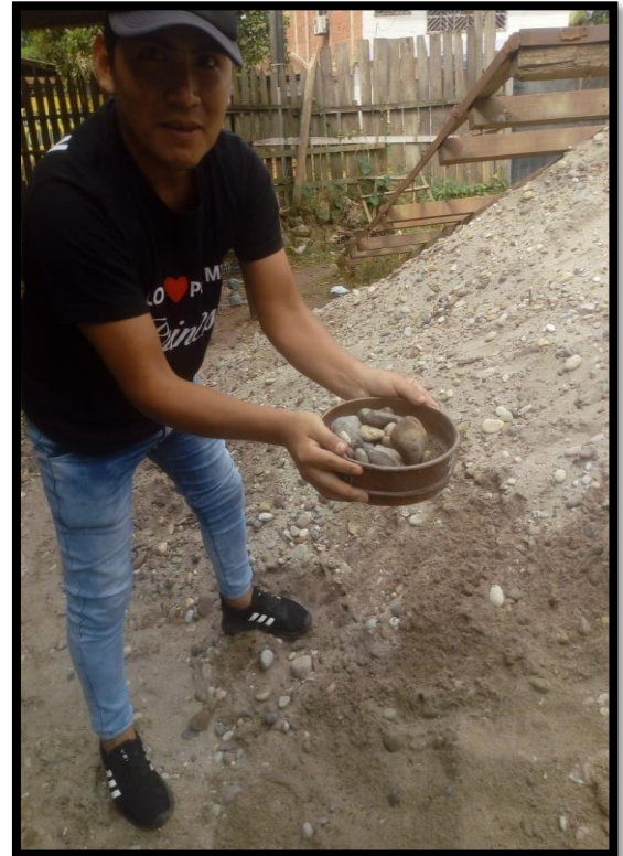
Figura 44 Zarandeo de hormigón para selección de grava TMN 3/4".
