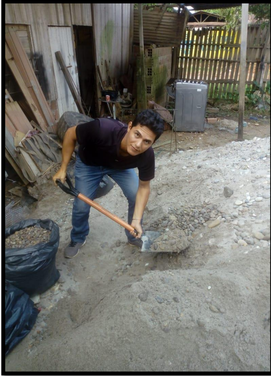
Figura 43 Zarandeo de hormigón para selección de grava TMN 3/4".
