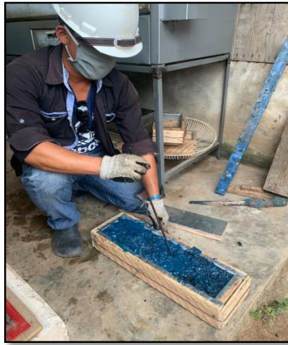
Figura 20. Mezcla en Molde Pequeño Antes de Compactar
