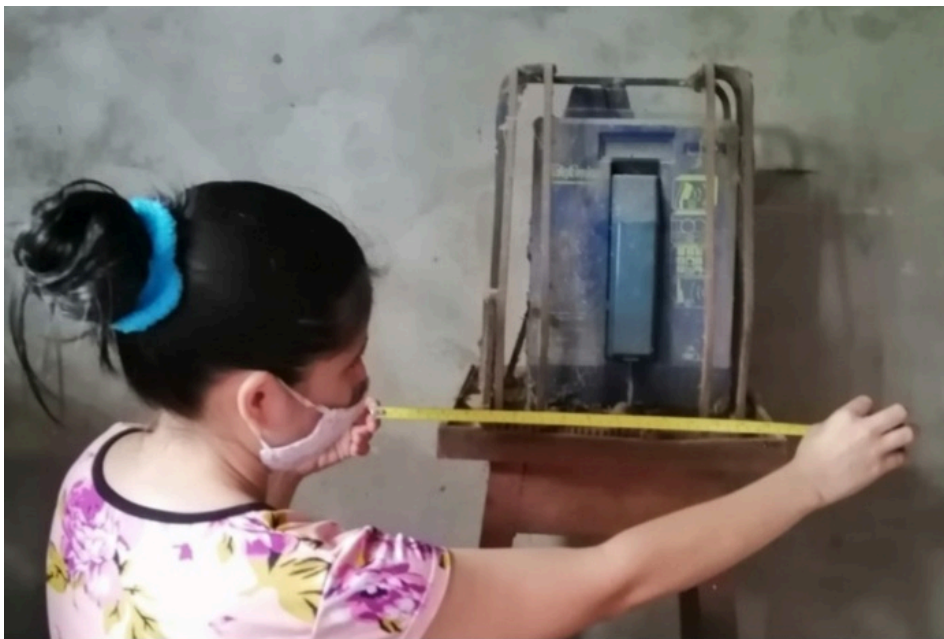
Figura 2. Verificación en campo fotografía 2
