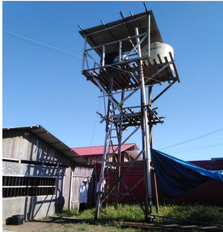
Figura 3. Pozo de abastecimiento N° 02
