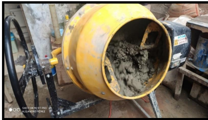
Figura 22: ELABORACION DE LA MEZCLA DE MORTERO.
