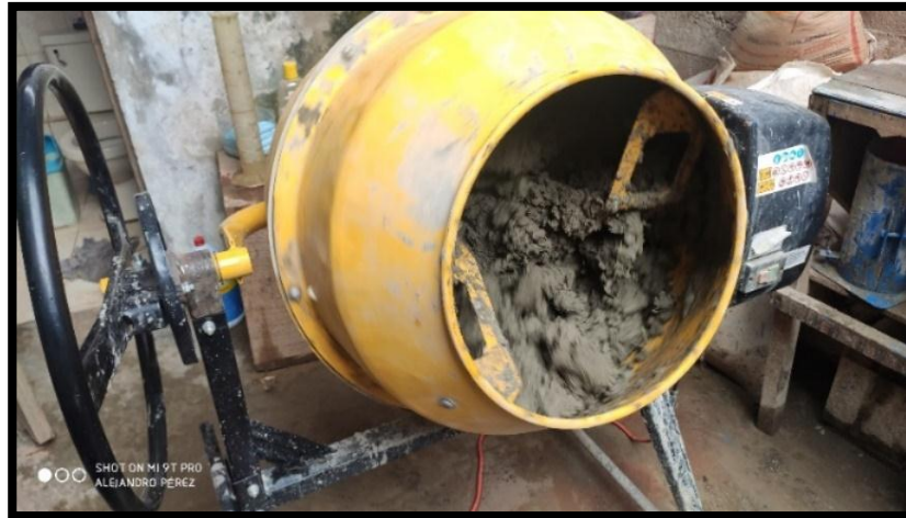
Figura 22: ELABORACION DE LA MEZCLA DE MORTERO.
