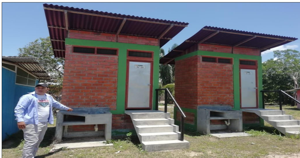
Figura 26. Vista del sistema de saneamiento construido por el MVCS
