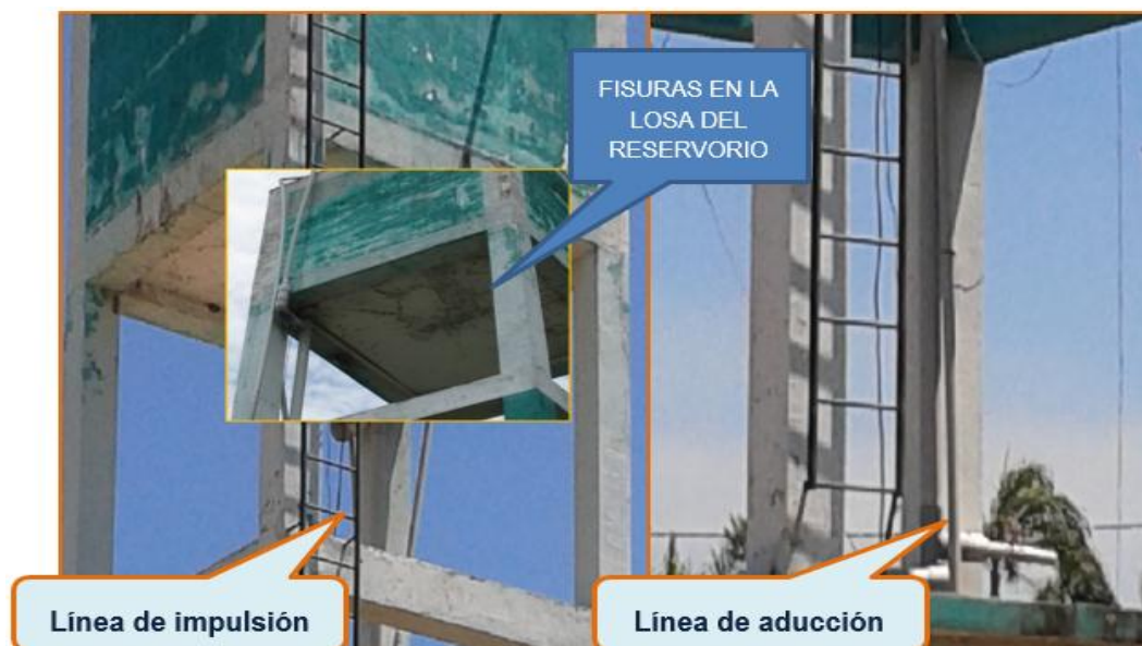
Figura 35. Situación actual del sistema construido por la Municipalidad de Campo Verde
