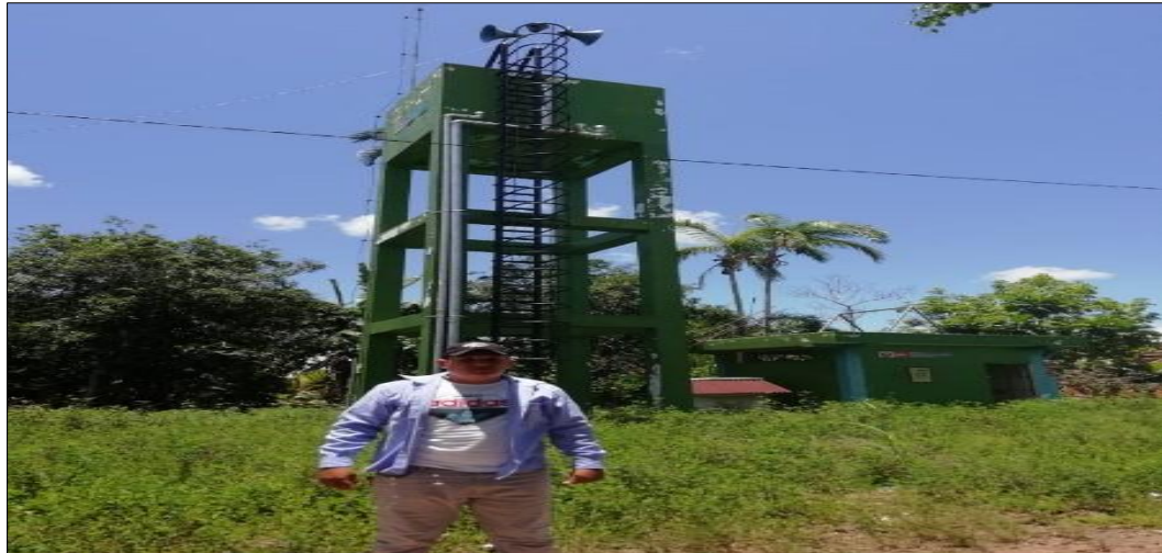
Figura 18. Sistema actual de agua mediante pozo tubular
