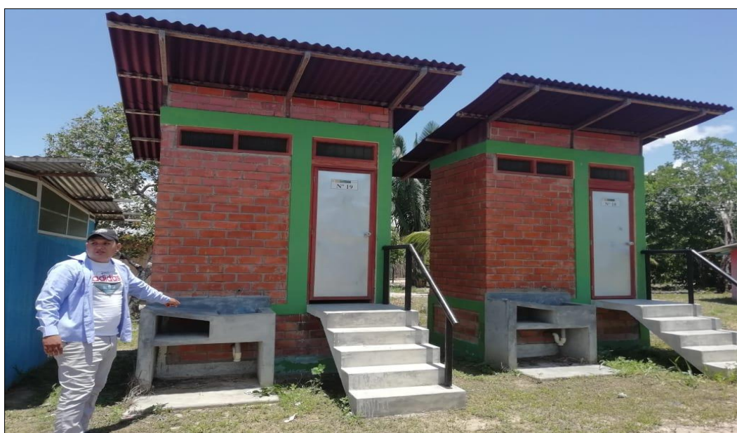
Figura 20. Unidades Básicas de Saneamiento tipo UBS – Composteras
