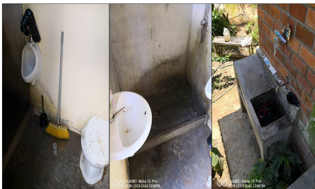
Figura 27. Vista de los componentes de la UBS.
