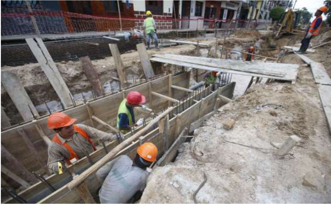
Foto 3. Construcción de alcantarillado en el distrito de Manantay.
