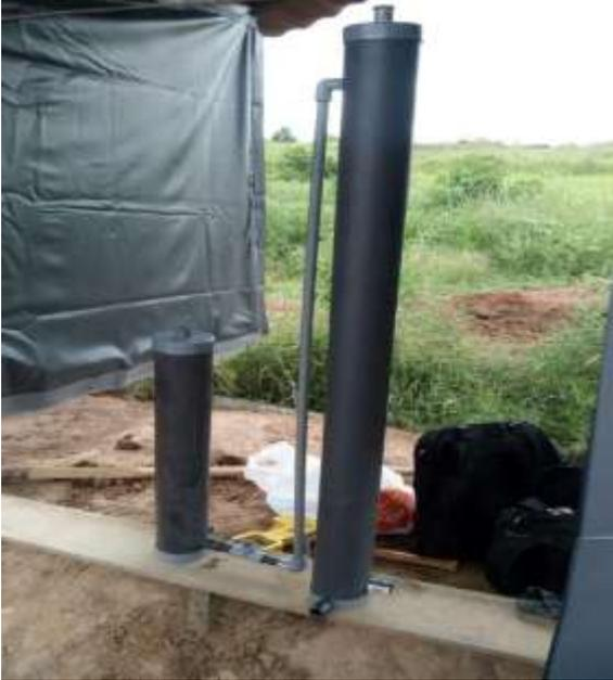
**Figura 38.** Filtros de sulfuro colocados de forma vertical por donde pasa el biogás y llega a los gasómetros.
