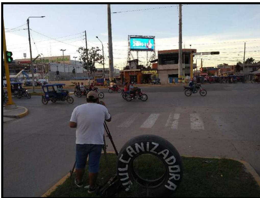
Imagen 81: Realizando el levantamiento topográfico de la intersección I-04
