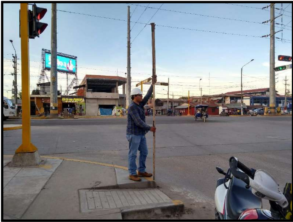
Imagen 82: Realizando el levantamiento topográfico de la intersección I-04
