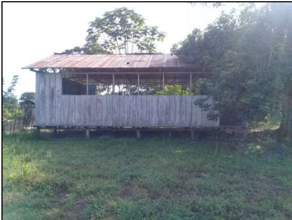
Fotografía 10. Local Comunal del Caserío Santa Cecilia de Pacache.
