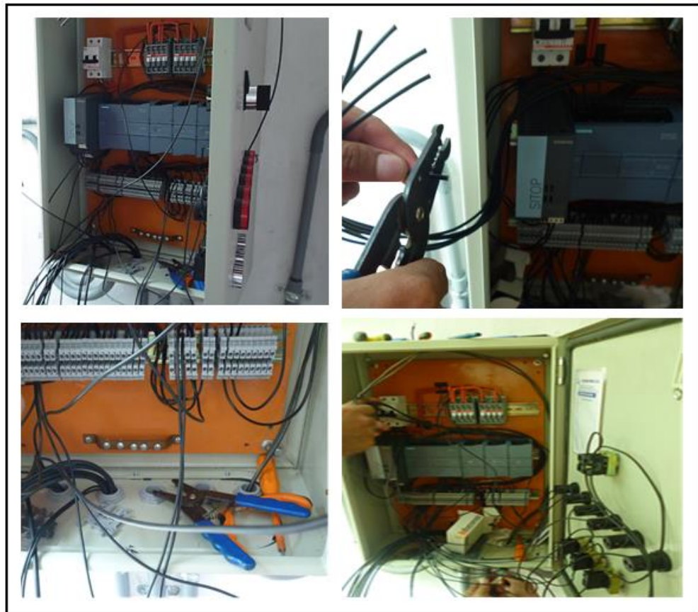
Ilustración 104: Instalación del cableado eléctrico y electrónico
