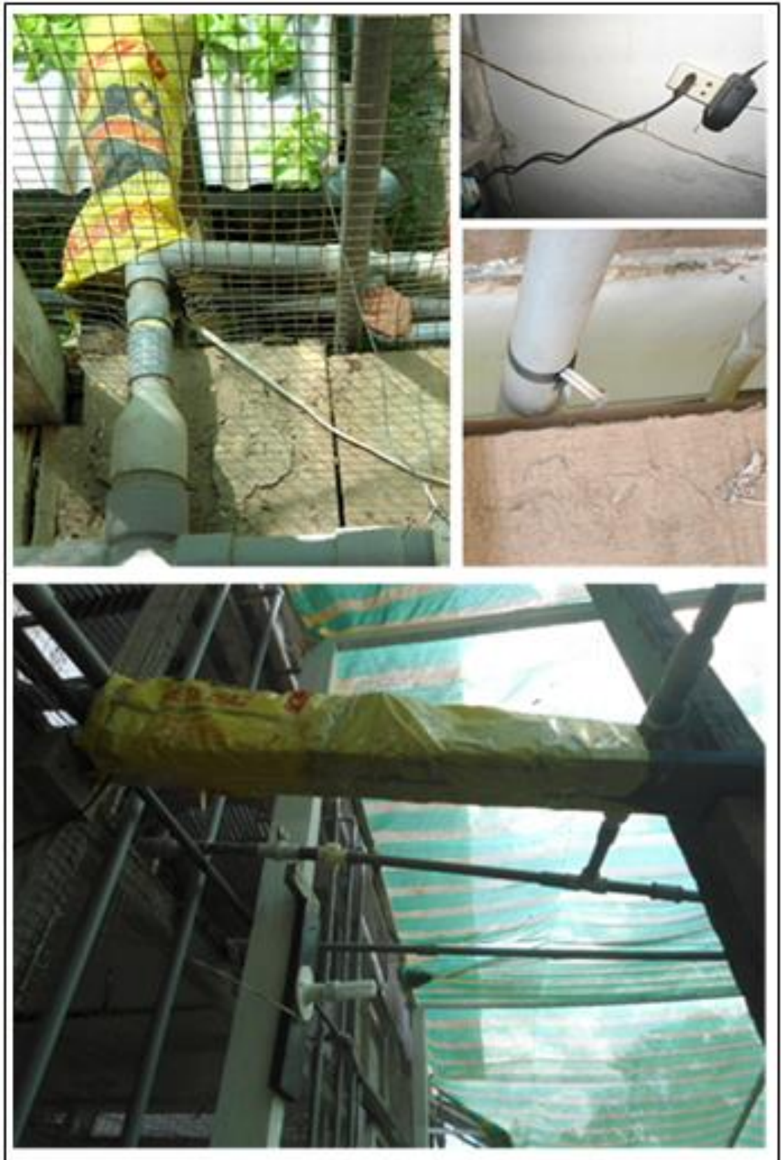
Ilustración 135: Instalación del motor Tricó protegido de la lluvia con plástico
