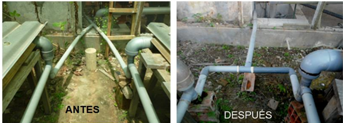
Ilustración 163: Cambios en las conexiones de tubos de reciclaje de solución nutritiva.
