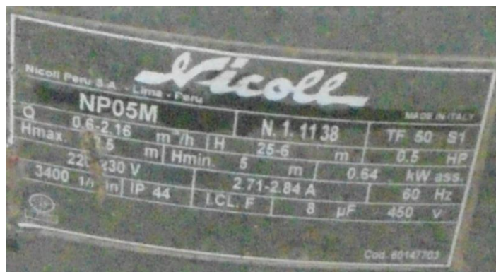
Ilustración 75: Características de la bomba
