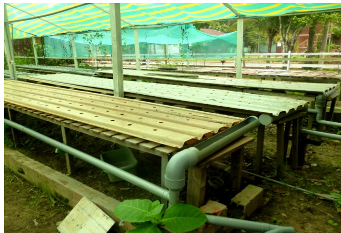
Ilustración 162: Instalación de las canaletas y tubería
