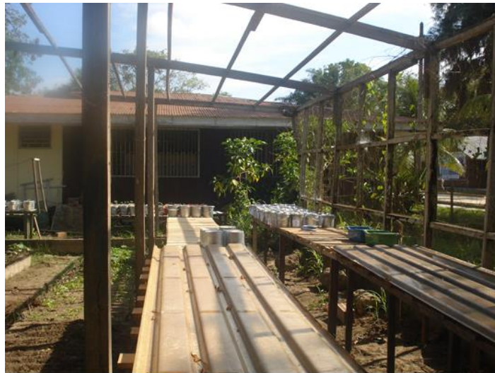
Ilustración 83: Colocación de las planchas de fibra de vidrio encima de la mesa de madera
