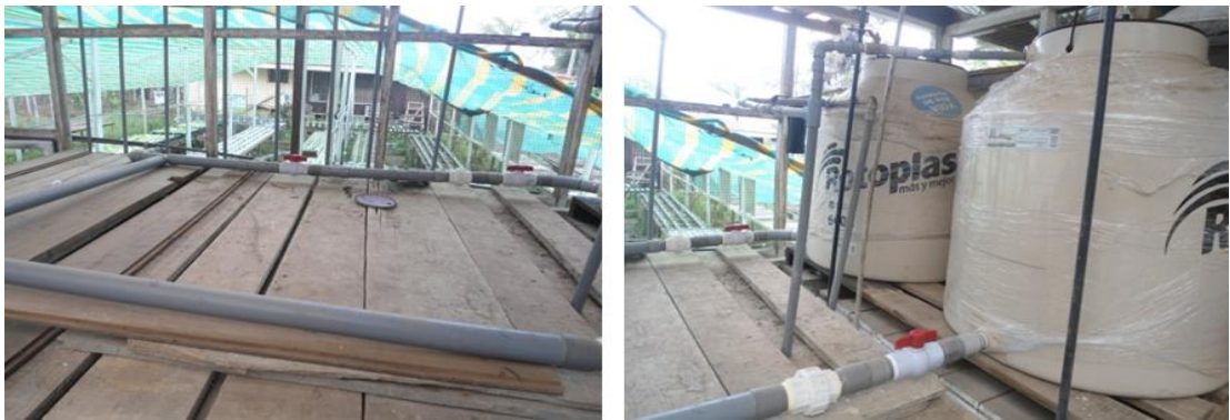
Ilustración 305: Conexiones de las canaletas de recolección
