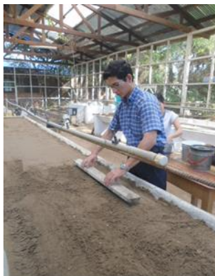
Ilustración 176: Nivelación de la arena y a compactación ligera.
