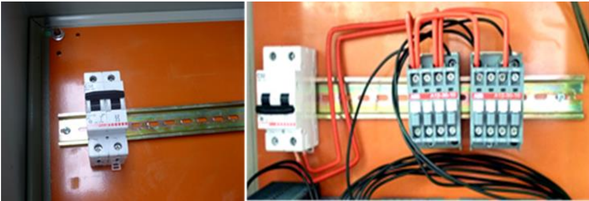
Ilustración 98: Instalación de las borneras
