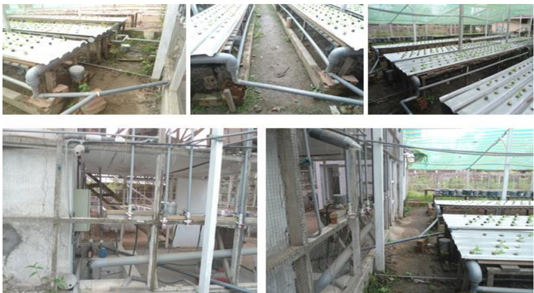
Ilustración 305: Conexiones de las canaletas de recolección
