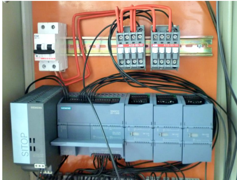
Ilustración 104: Instalación del cableado eléctrico y electrónico
