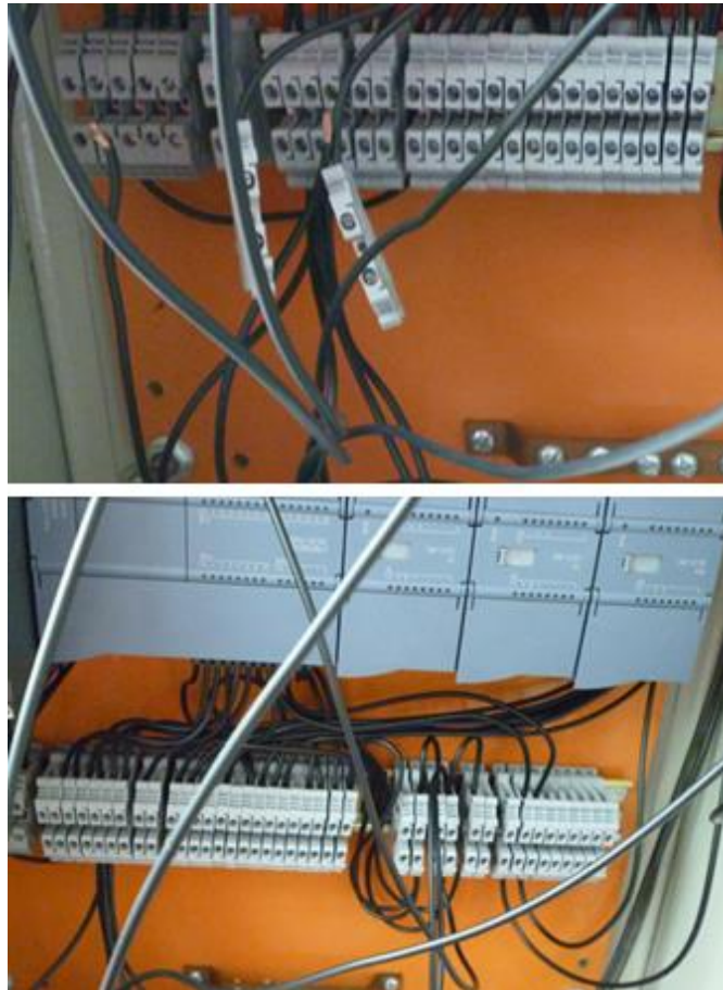
Ilustración 106: Ordenando los cables con sujetadores y tubos aisladores
