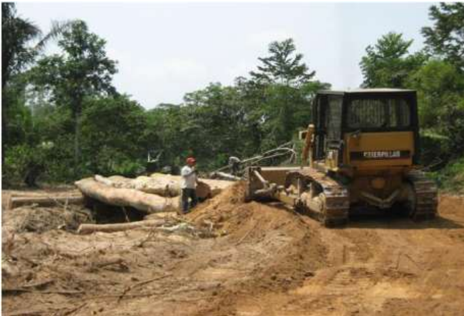
Construcción de puentes
