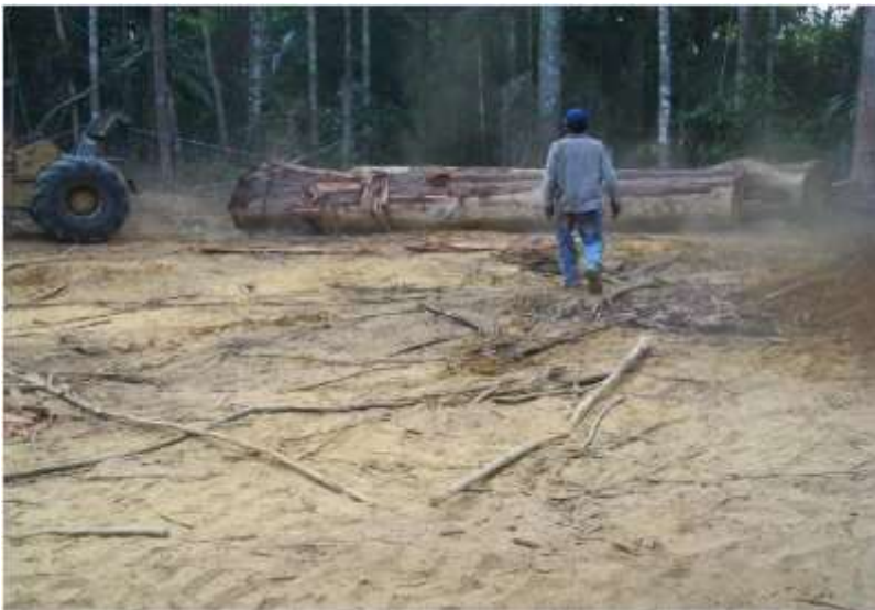
Compactación de suelo en patio de acopio
