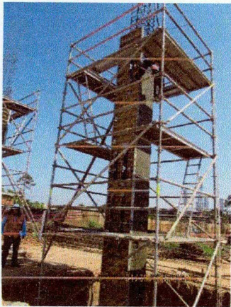
Imagen N° 31: Se observa encofrado de columna.
