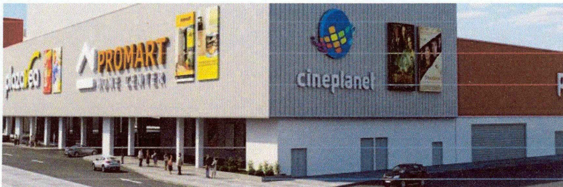
Imagen No 13: Prototipo de Obra finalizada
