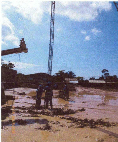
colocacion de armadura pilote 249
