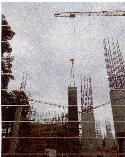
Imagen N° 19: Se muestra izaje de encofrado vertical con la torre grúa.
