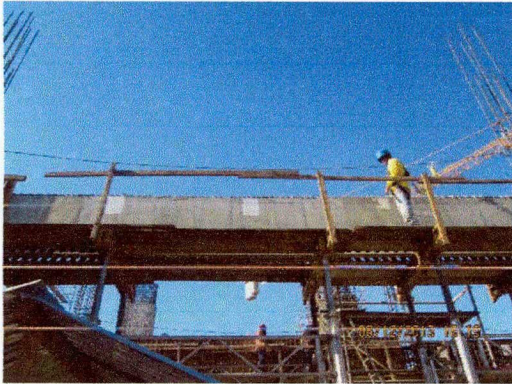
Imagen N° 27: Se observa la colocación de tarjeta en el inserto metálico, para la colocación de viga metálica.
