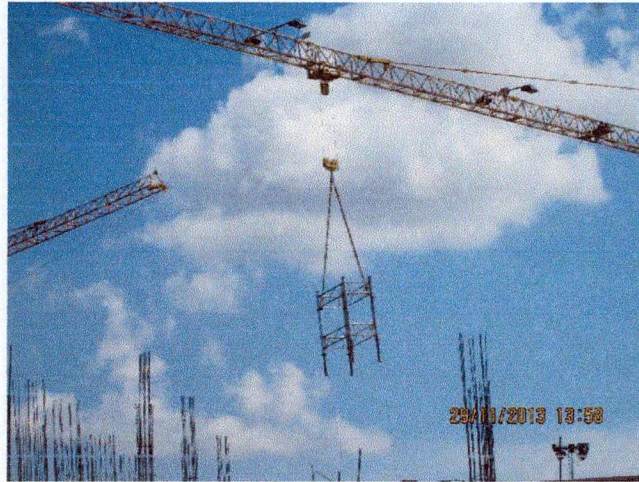
Imagen N° 04: Acarreo de materiales para encofrado de fondo de viga.
