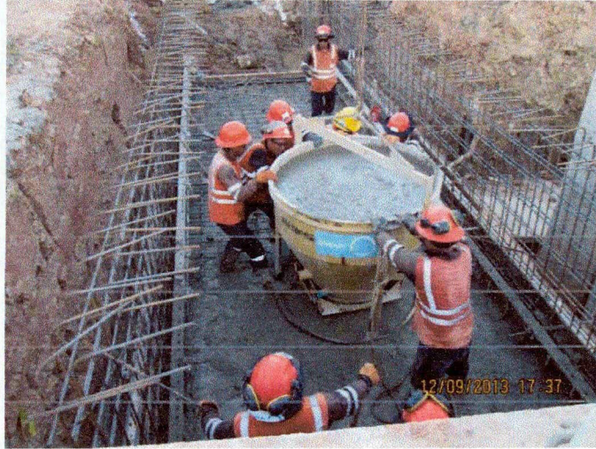
Imagen N° 08: Vaciado de Zapata
