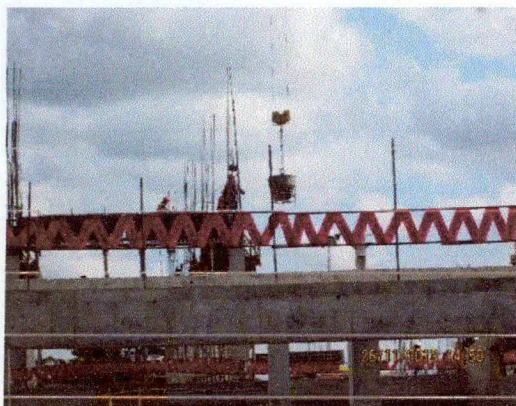
Imagen N° 21: Se muestra izaje de balde de concreto para colocación de concreto en viga con la torre grúa.
