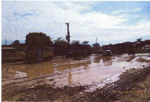
perforacion para construccion del pilote 249
