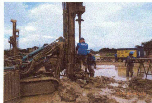
proceso de perforacion con ambos equipos apartir de las 13:00 hrs
