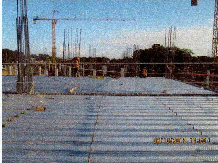
Imagen N° 03: Espera que ingresa la cuadrilla de fierro.
