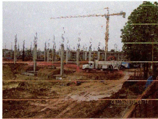
Imagen N° 26: Se observa planta móvil de concreto en la construcción del centro comercial real plaza.
