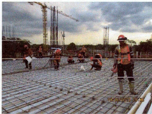
Imagen N° 30: Se observa colocación de malla de acero para temperatura y limpieza para su vaciado.
