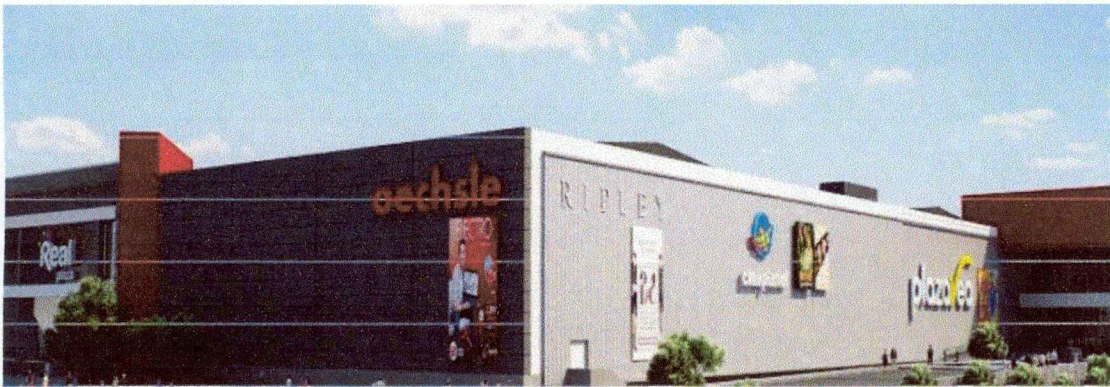
Imagen No 12: Prototipo de Obra finalizada
