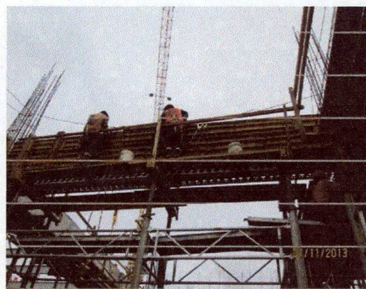
Imagen N° 17: Se muestra el trabajo de colocación de tensores en el estudio 07.
