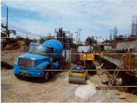
Imagen N° 25: Se observa planta móvil de concreto descargando concreto dosificado al camión mixer.
