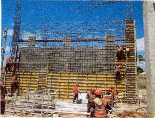
Imagen N° 33: Se observa colocación de encofrado de placas con moldes metálicos.
