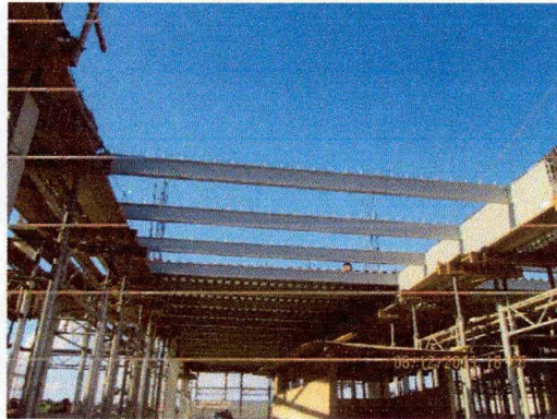
Imagen N° 28: Se observa la colocación de viga metálica para posterior colocar la placa colaborante.
