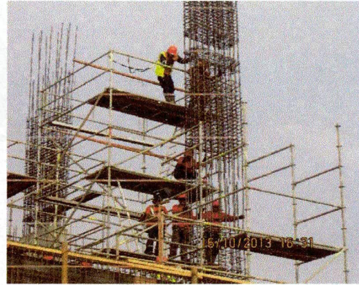
Imagen N° 38: Se observa uso de andamios para colocación de acero en columna.
