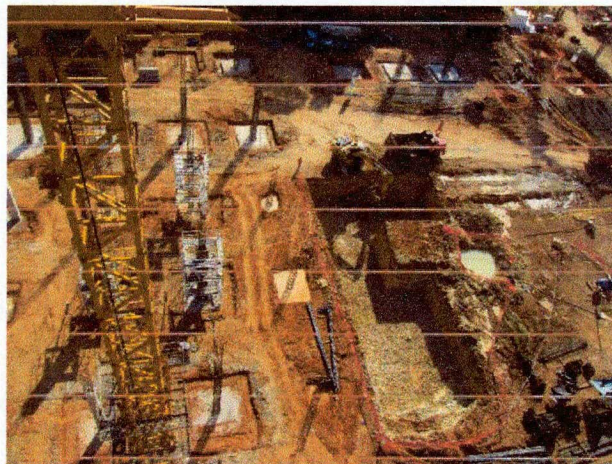
Imagen N° 41: Se muestra la excavación molde de queso.
