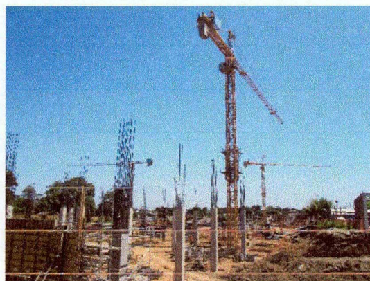
Imagen N° 22: Se observa las tres torres grúa en la construcción del centro comercial real plaza.
