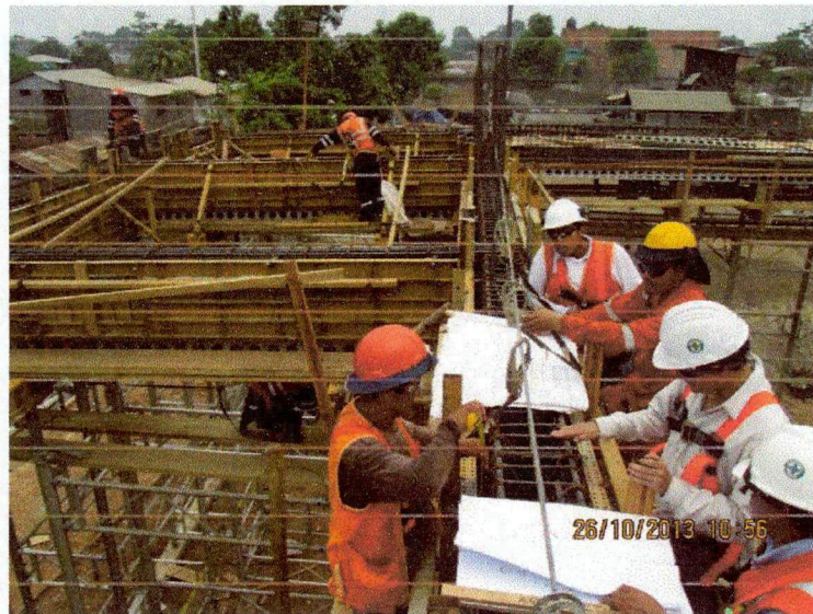
Imagen N° 09: Verificación de trabajo realizado por la Supervisión
