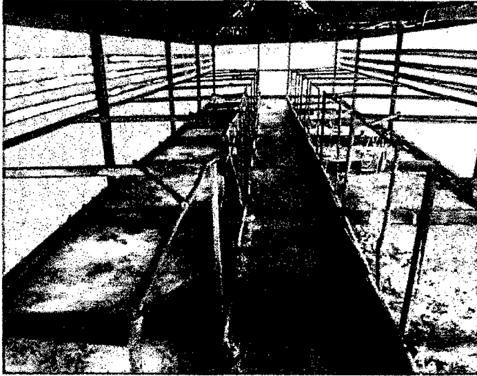
Foto 01. Acondicionamiento del galpon
